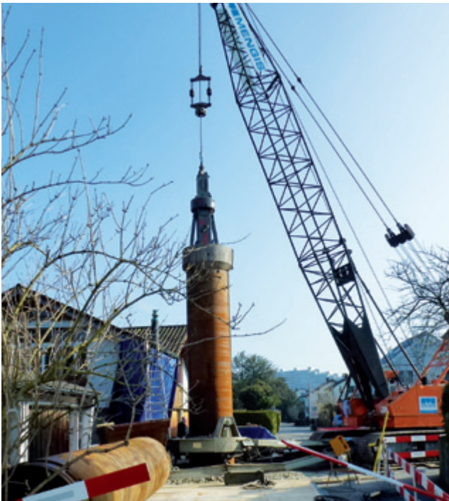
Erstellung des Grundwasserbrunnens am Tuchs Schmidweg.
